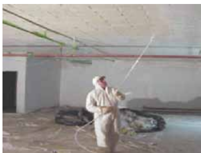
...całego obszaru powierzchni sufitu
