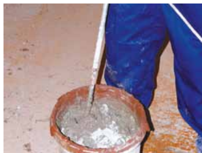
Przygotowanie zaprawy klejowej
