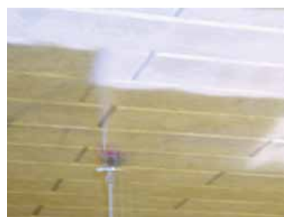
...powierzchni płyt izolacyjnych cienką warstwą farby...
