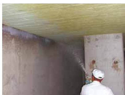
Przyklejone płyty gotowe do malowania
