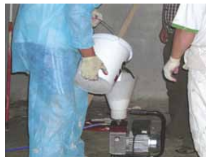
Napełnianie zbiornika agregatu farbą
